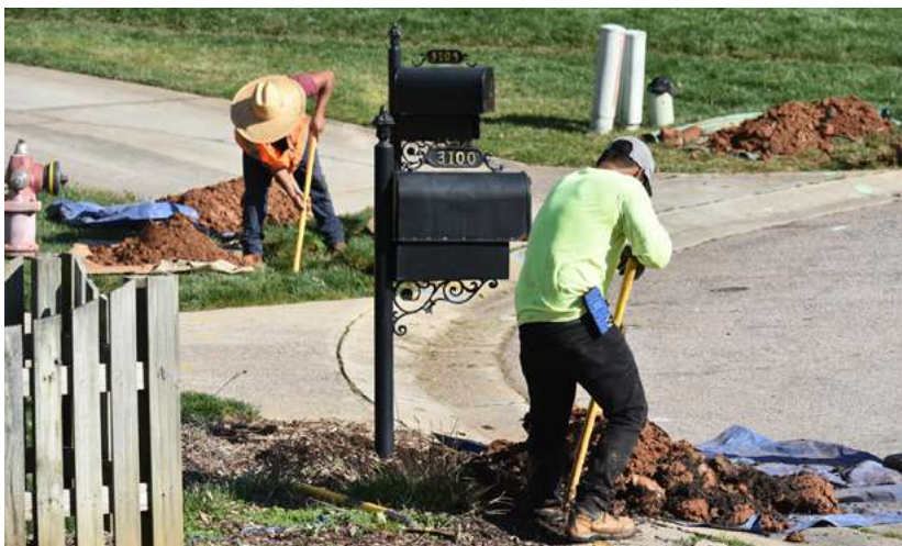
Trabajadores instalando fibra óptica en una calle. Foto: Adobe Stock.
